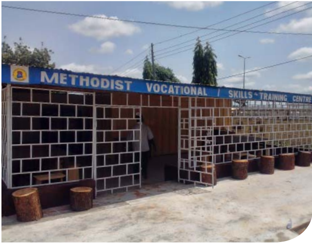
Die Methodistische Kirche Ghana hat bereits begonnen, das Ausbildungszentrum zu bauen
